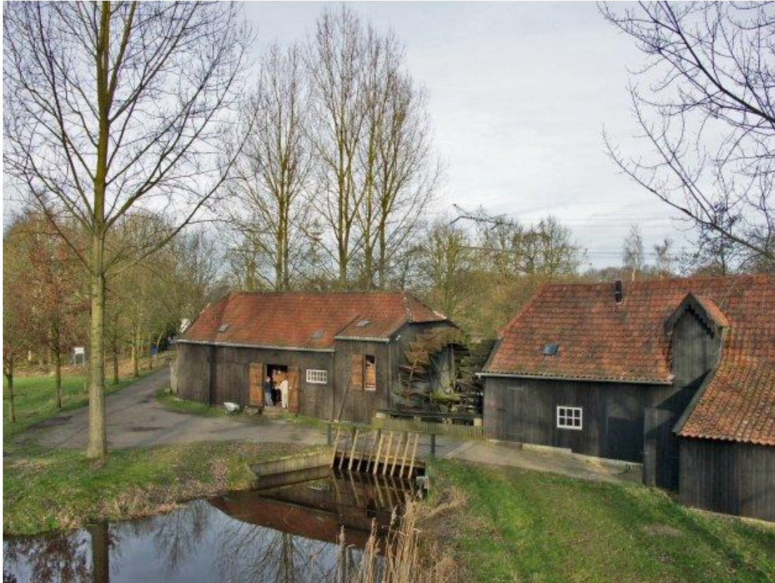
Die Collse Wassermühle mit zwei Rädern und mit roten Dächern. © Photo: Norbert van Eekeren, Nuenen, feb. 2007 Ansicht aus dem Süden.
